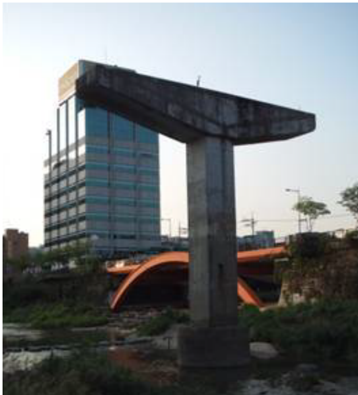
高架道路を撤去して清溪川がよみがえった。高架の橋脚のモニュメント。(由田麻奈)
