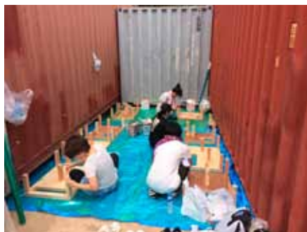
飛び石を塗装している様子
